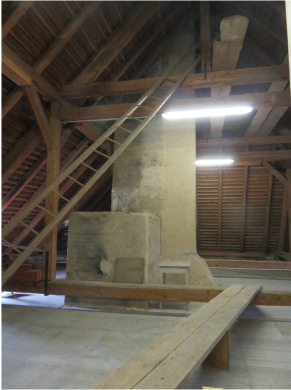
Abbildung 30.: Kamin auf dem Dachboden (Foto W. Oppeker)
